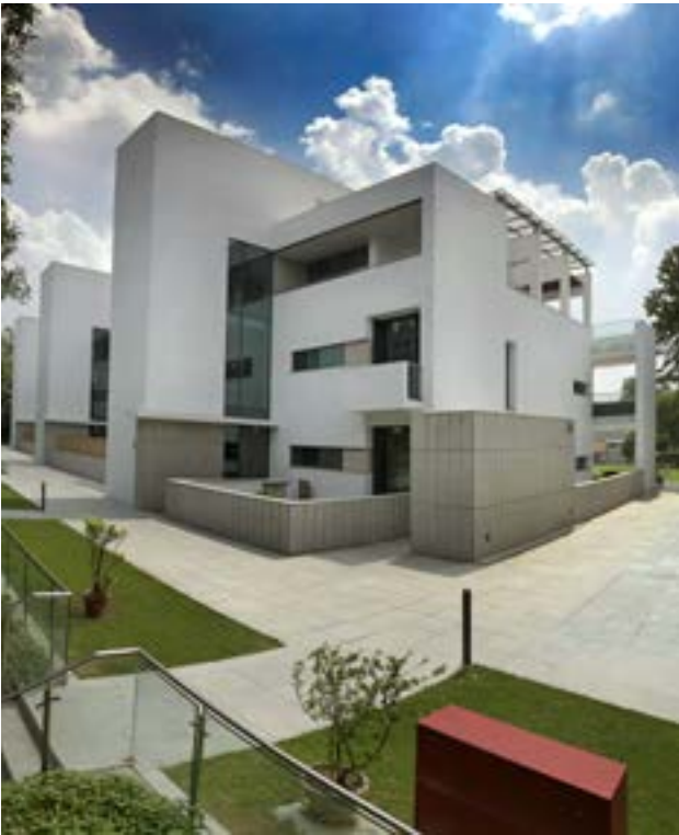
▲ Uteområdet er både felles og privat. Leilegheitene har privatisert framhage eller terrasse med forbindelse til rekreasjonsområda. Ei heving av grunnplanet til leilegheitsbygget over nivået på fellesområda gjer sonedelinga tydeleg.
