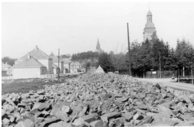
Bygging av Kirkeveien i 1931. Ukjent fotograf. Oslo Bymuseum.
