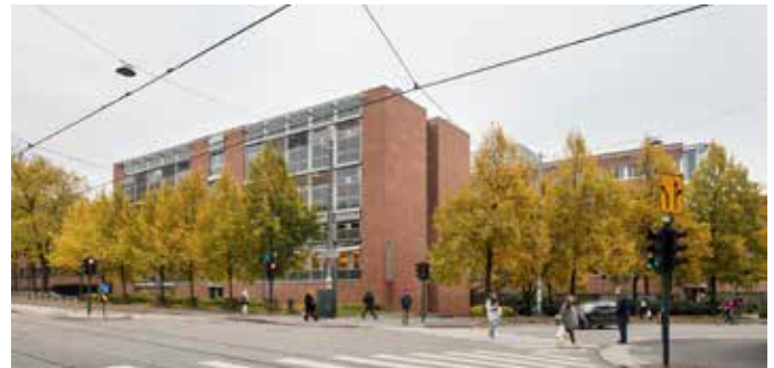
Prosjektområdet sett fra Ullevålsveien. Foto Trond H. Isaksen
