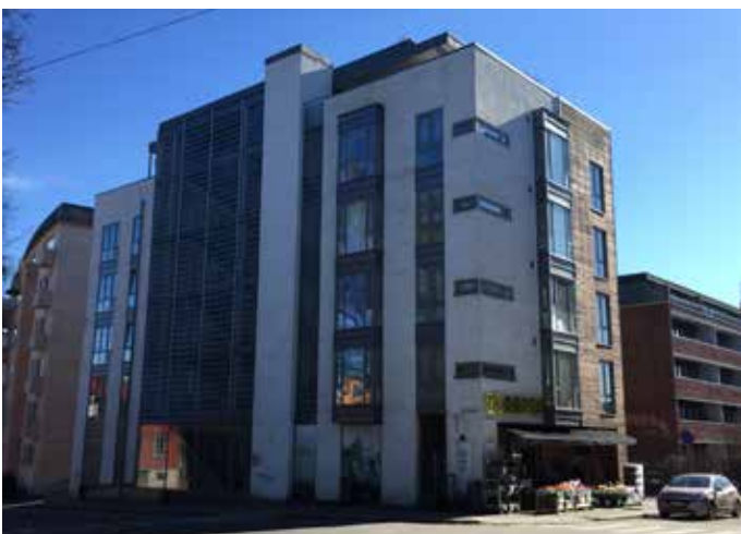
Bygård Ullevålsveien 105. Foto: Link arkitektur
