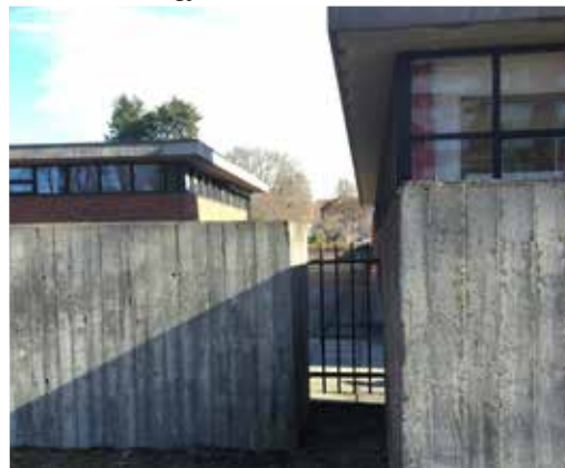
Mur mellom bygg 16 og 17 hindrer adkomst fra gate. Foto Link Arkitektur
