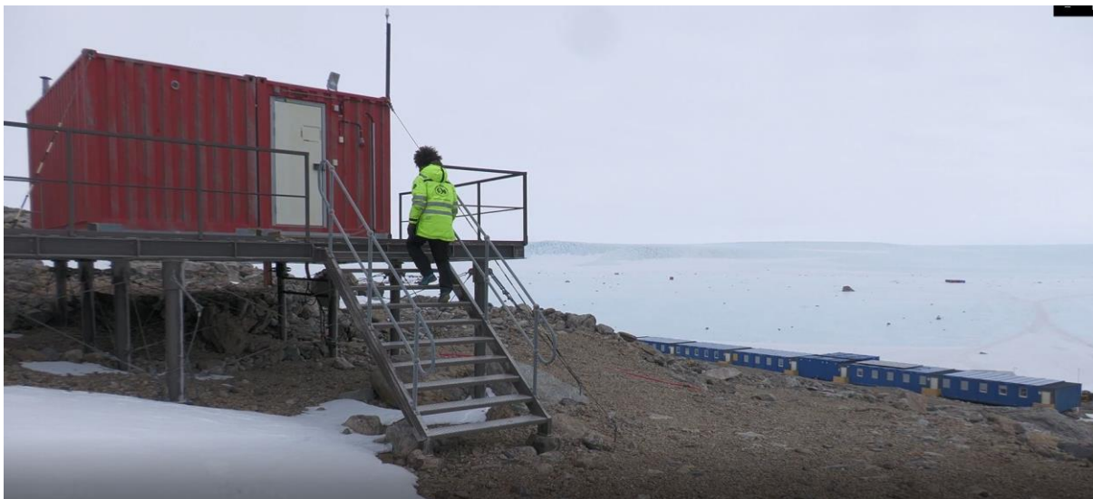
Figur 9 Dagens nødstasjon ved Troll (Norsk Polarinstitutt, 2022b)
