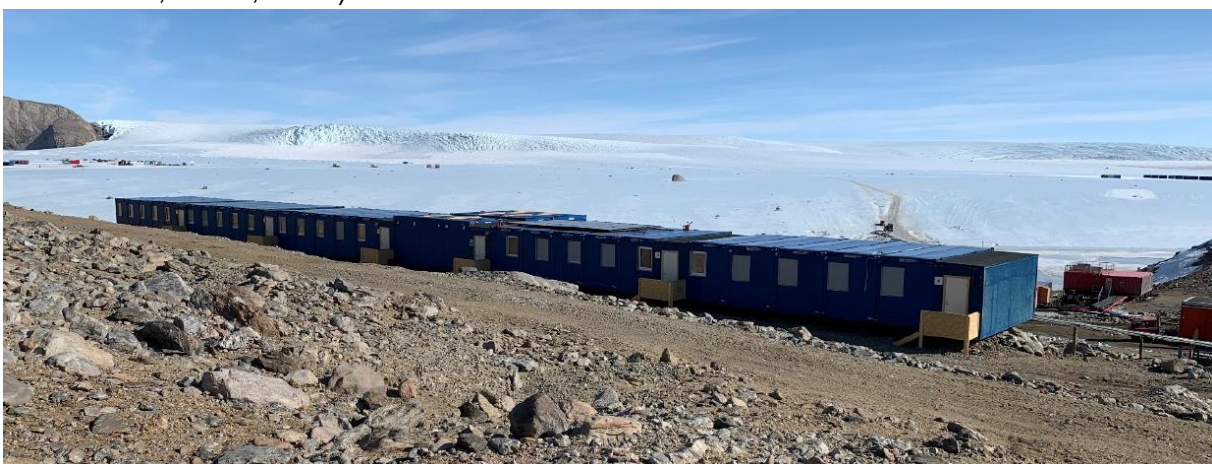
Figur 8 Blåbo består av en rekke sammenkoblede boligcontainere. WC og dusj er ikke koblet til anleggets sanitæranlegg på grunn av kapasitetsmangler (Statsbygg 2020a, s. 8)
