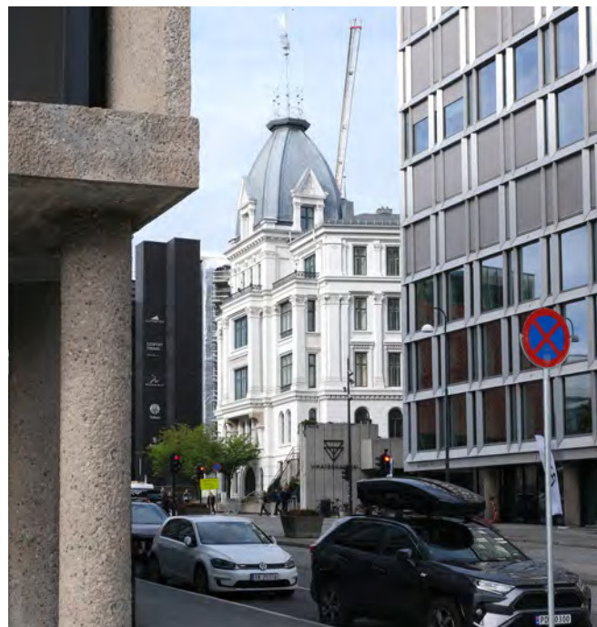
VICTORIA TERRASSE FRA DRONNING MAUDS GATE (Foto: Rodeo arkitekter)
